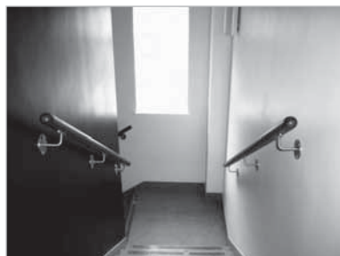
Slika 21. Rukohvati na stepeništu postavljeni zbog sprječavanja padova.
